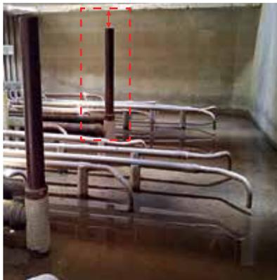
**Figura 4** – Tubulação de descarte de lodo posicionada muito próxima do defletor de gases, em desacordo com o projeto.
