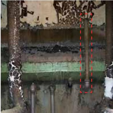
**Figura 3** – Instalação de ponto de amostragem de lodo bem acima do limite do compartimento de decantação, em desacordo com o projeto.
