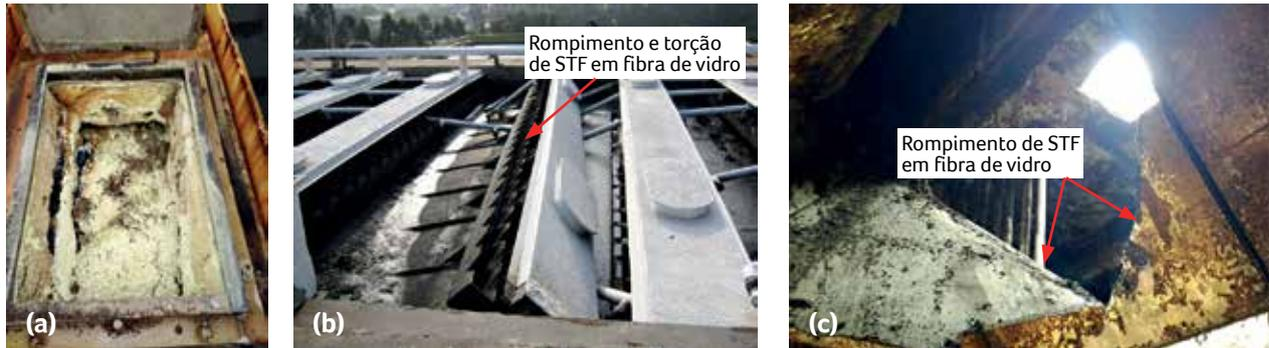
**Figura 11** – (a) Escuma solidificada no interior do separador trifásico; (b e c) Rompimento de separador trifásico.
