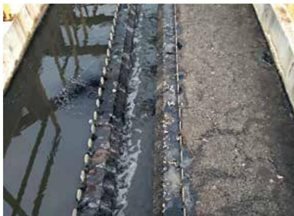
**Figura 4** - Acúmulo de espuma em decorrência de vertedores desnivelados.
