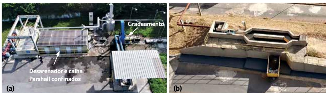
Figura 1 – Unidades do tratamento preliminar: a) Solução enterrada e enclausurada; b) Solução elevada.
