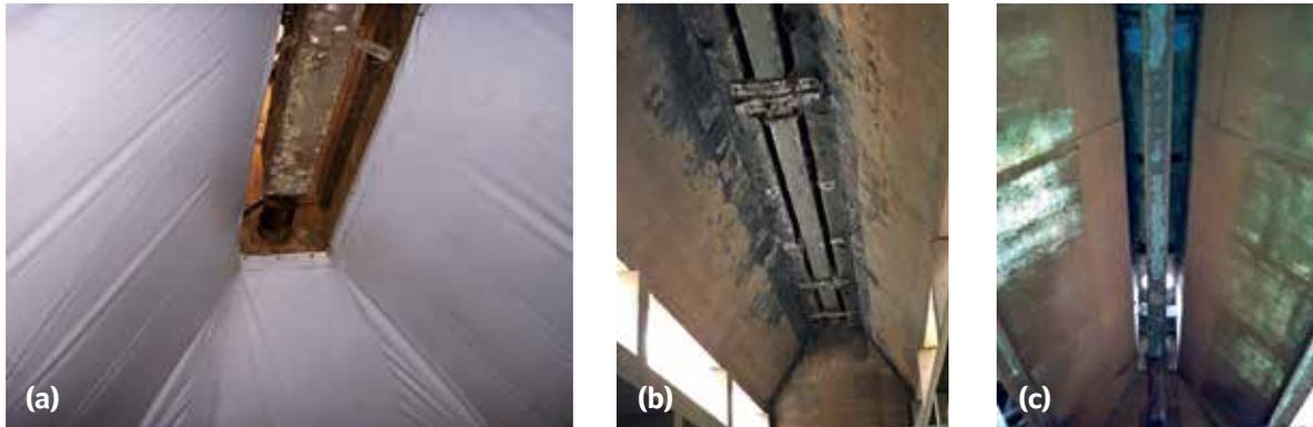
**Figura 12** – Separadores trifásicos com canaleta interna de coleta de espuma: a) STF confeccionado em concreto e lona, com canaleta em alumínio; b) STF confeccionado em concreto, com canaleta em PRFV; e c) STF confeccionado em PRFV, com canaleta em PRFV.
