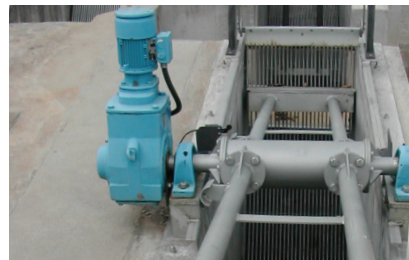
Grade fina de limpeza mecanizada
