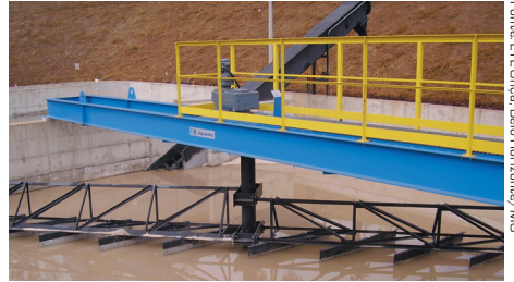
Desarenador de limpeza mecanizado
