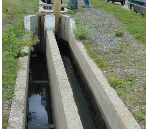
Caixa de areia de limpeza manual
