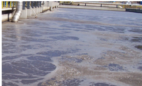
Tanque de aeração
