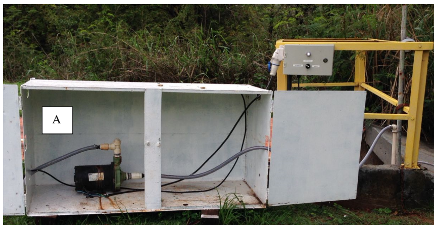
Figura 4.2 - (A) Bomba de Esgoto
